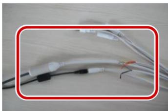
2. Обмотайте соединённые кабели изоляционной лентой.
